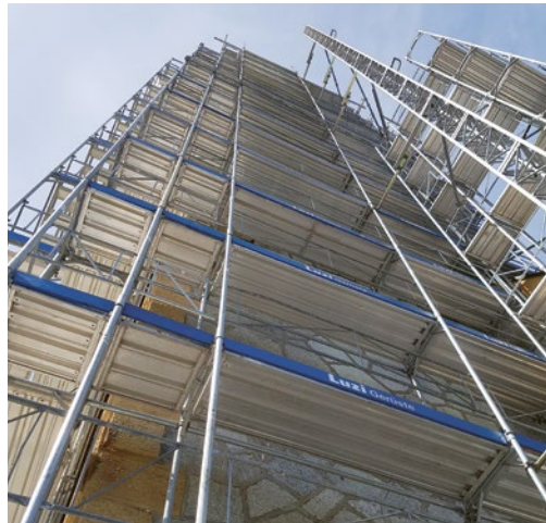
Nicht nur der Kirchturm ist eingerüstet,
